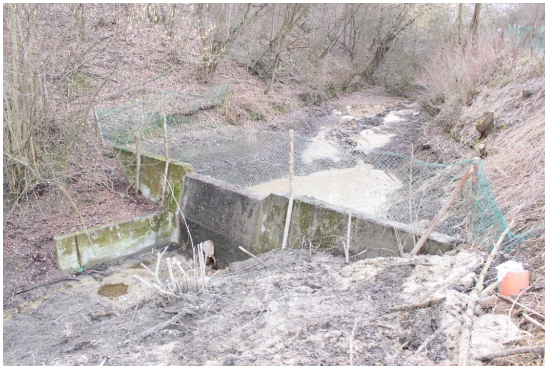
Rysunek 34. Przegroda w wąwozie dolinowym w Wólce Gierszowskiej. (fot. R. Wawer)
